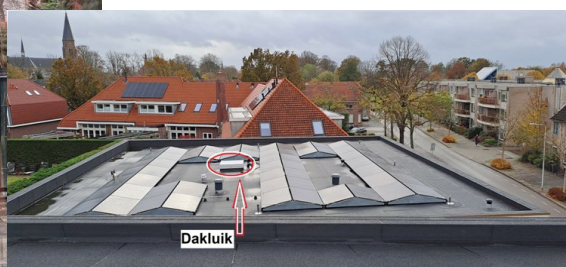
Uitzicht op het lage dak met de zonnepanelen
