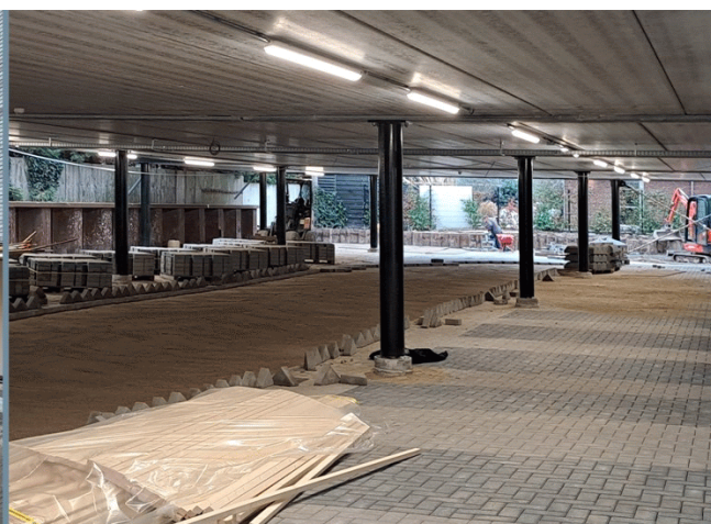
Aanbrengen bestrating in de parkeergarage en voor het gebouw
