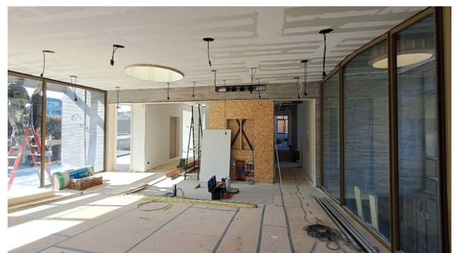
Overzicht werkzaamheden hal
