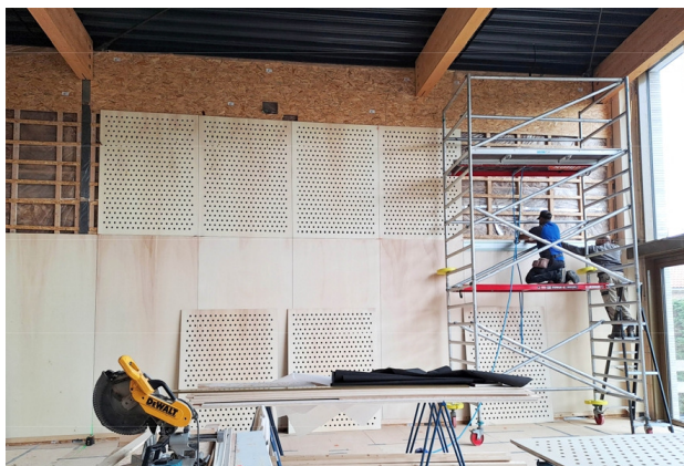
Aanbrengen akoestische beplating Grote Zaal
